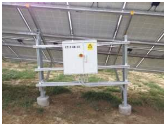
Slika 3, Slika 4: Pretvarači i SPMO ormar elektrane GR.E2
