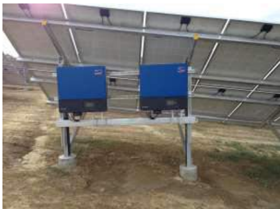
Slika 3, Slika 4: Pretvarači i SPMO ormar elektrane GR.E2
